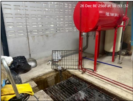
โครงการจัดให้มีเจ้าหน้าที่คอยตรวจสอบและตัดกากไขมันออกจากบ่อดักไขมันอย่างสม่ำเสมอ และทำความสะอาดทุกครั้งเมื่อตักเสร็จ
