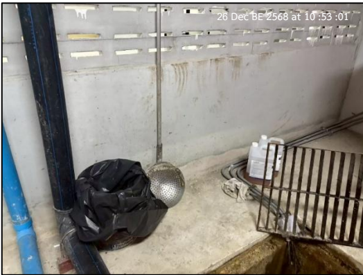
โครงการจัดให้มีเจ้าหน้าที่คอยตรวจสอบและตัดกากไขมันออกจากบ่อดักไขมันอย่างสม่ำเสมอ และทำความสะอาดทุกครั้งเมื่อตักเสร็จ
