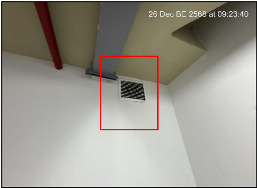
ระบบระบายอากาศ และท่อดูดควันจากห้องครัวของโครงการ
